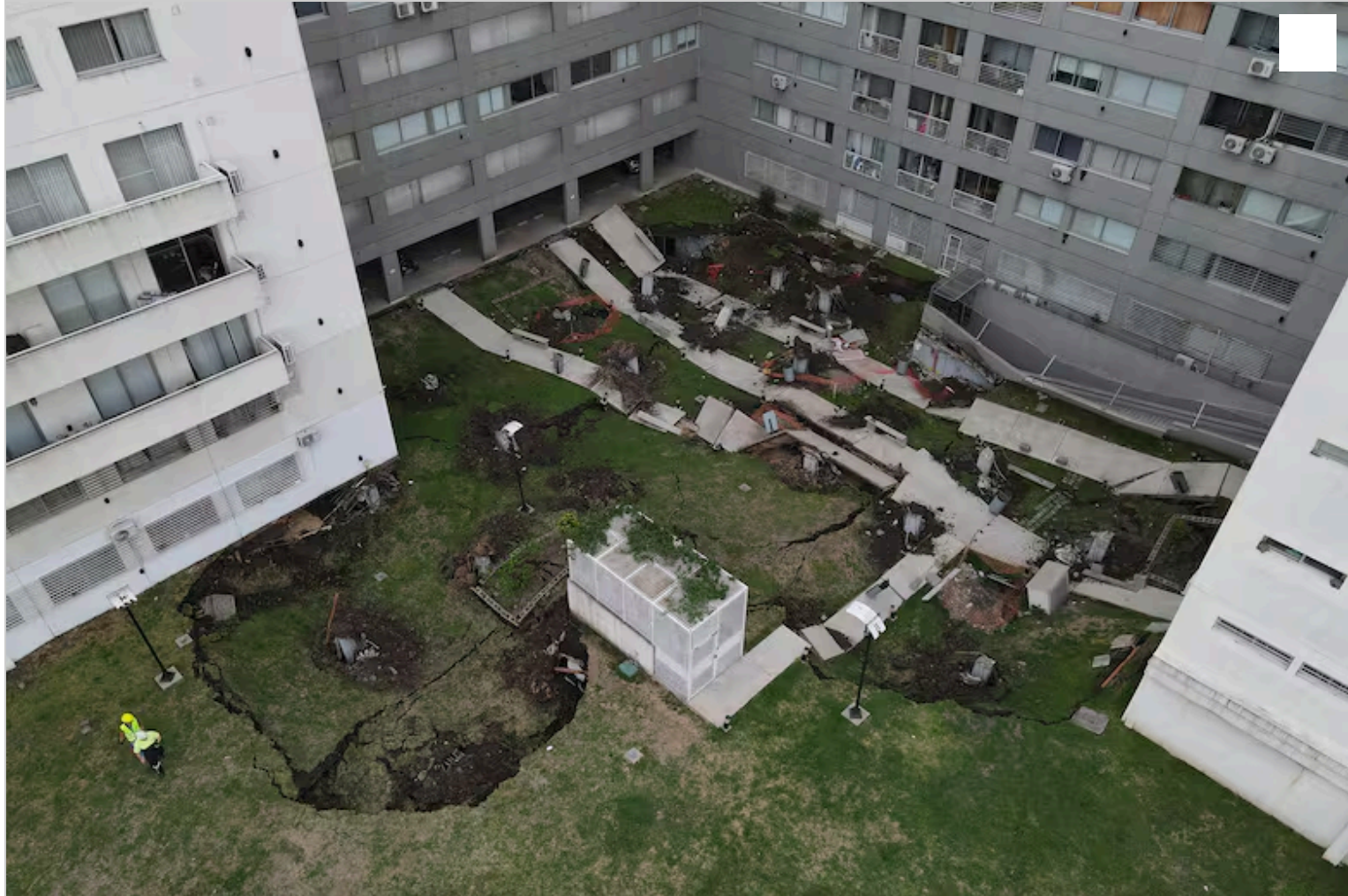
Así quedó el jardín central del complejo luego del derrumbe Ricardo Pristupluk
